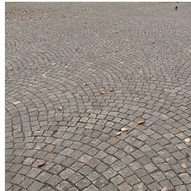
Foto på den befintliga beläggningen av smågatsten som finns på stora delar av torget.
